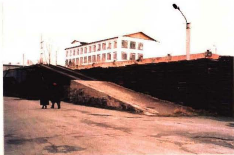
ビシュケーク市内保冷倉庫全景
