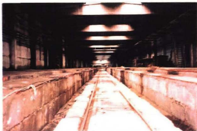
ビシュケーク市内保冷倉庫引き込み線
