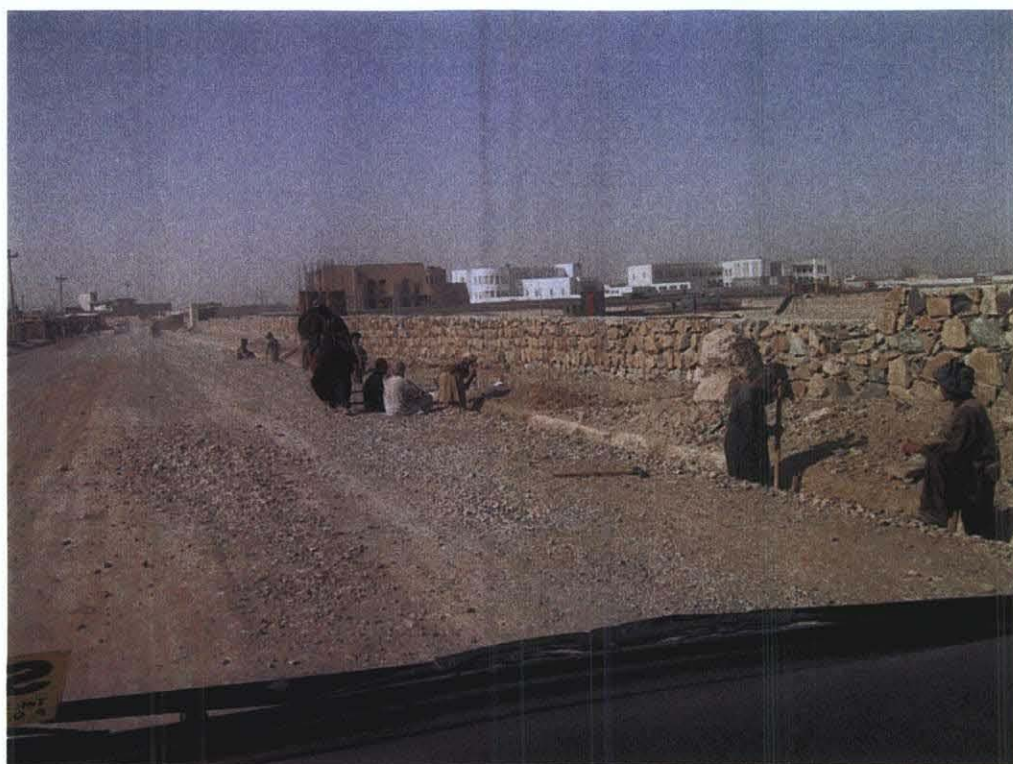
写真 7-37 カンダハール市内道路側溝建設作業
