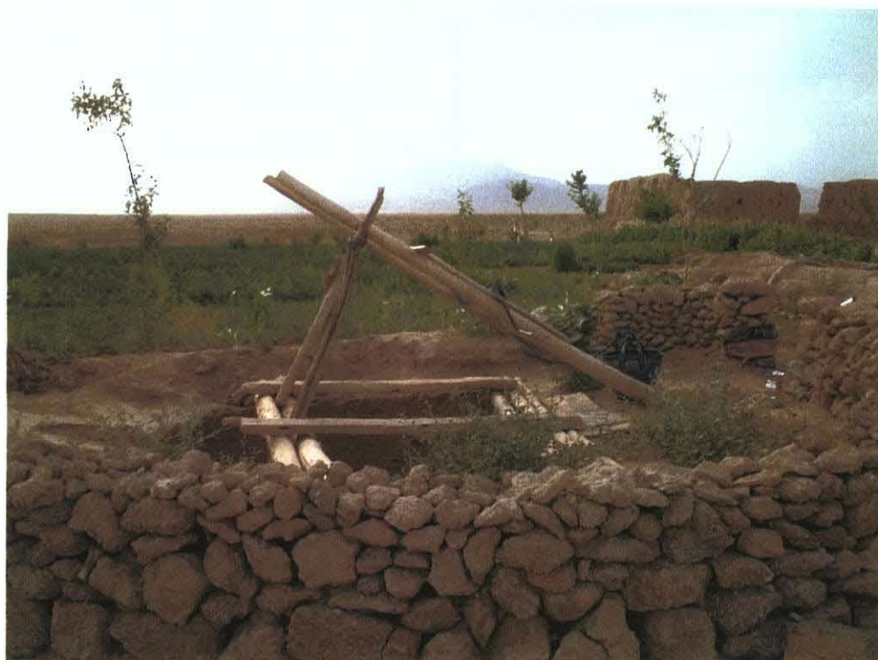
写真 7-12 地下水灌漑施設(たて坑)
