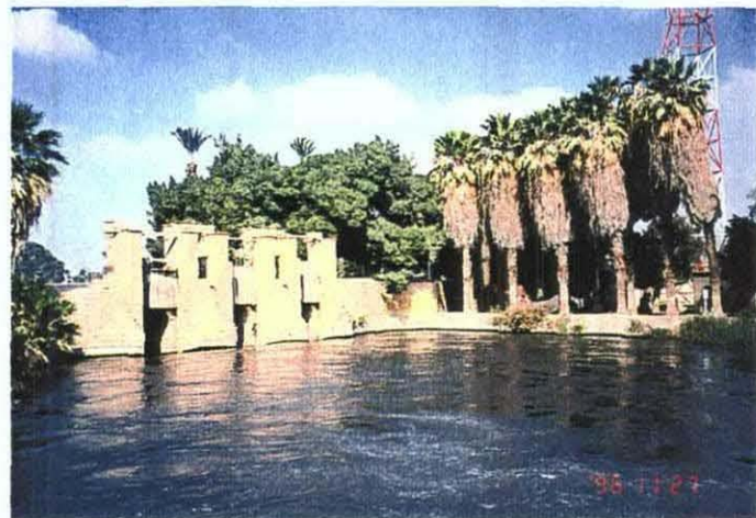
デルタ・バラージュ取水工
