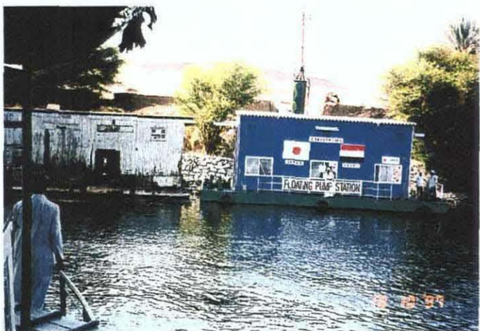
フローティングポンプ（無償実施）
