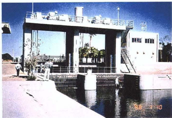
バハルヨセフ用水路ラフーン堰（無償実施）
