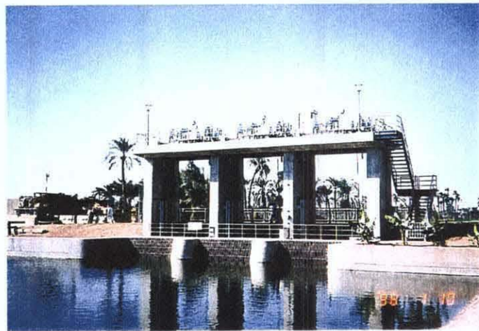
バハルヨセフ用水路ラフーン堰左岸分水工（無償実施）
