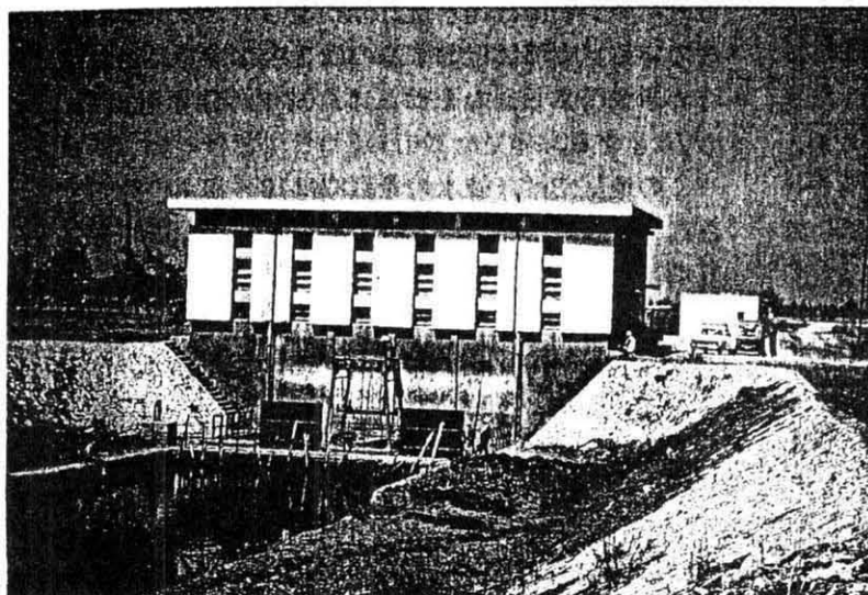
写真8 Khandak El-Gharby 地区の排水再利用のためのポンプ機場と連絡水路
