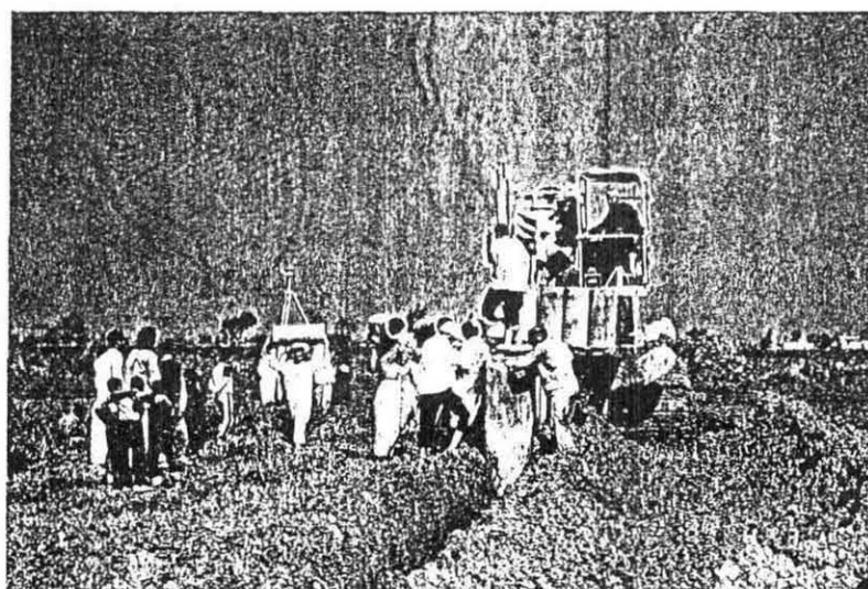
写真7 集水渠の機械施工(トルーガ地区)
