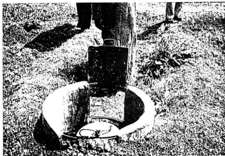
写真4 バイブラインシステムのアウトレット(アロス地区)
