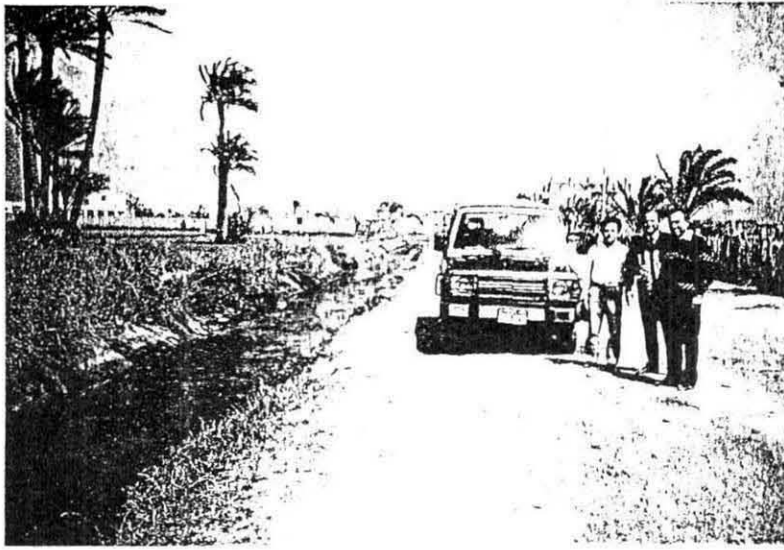
写真1 マンスーリヤ地区におけるメスカの改良 (メスカをライニングすることにより、水路幅が大幅に減少した。)
