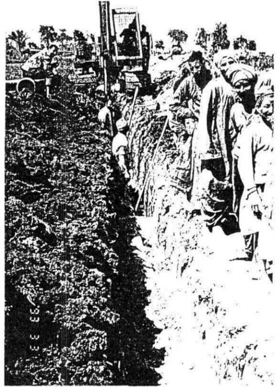
写真2 ナイルバレーのケーマン&カシヤ地区におけるパイプラインの敷設
