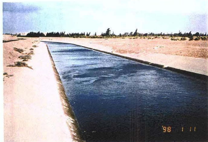
シェルキヤ県営カッターラ農場付近支線用水路
