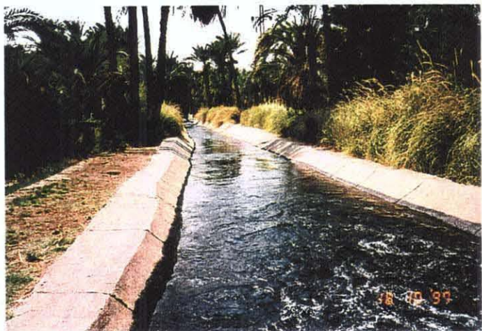
フローティングポンプ用水路
