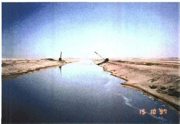
北シナイ・エルサラーム水路支線水路
