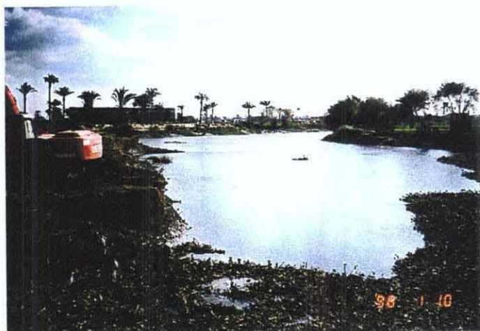
バハルヨセフ用水路マゾーラ堰上流水路
