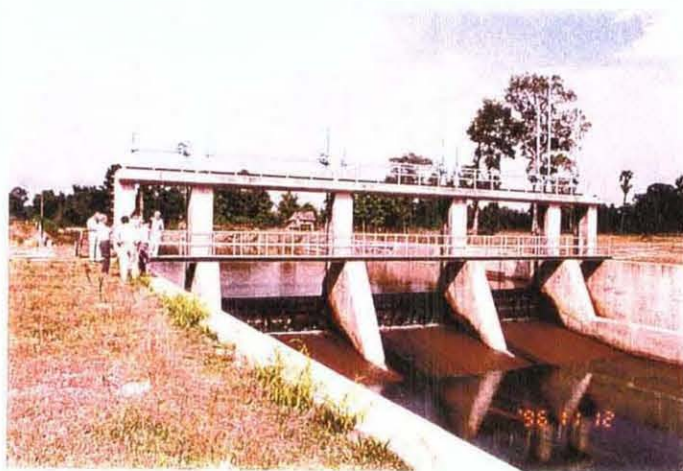
サバナケート農業総合開発計画（頭首工）
