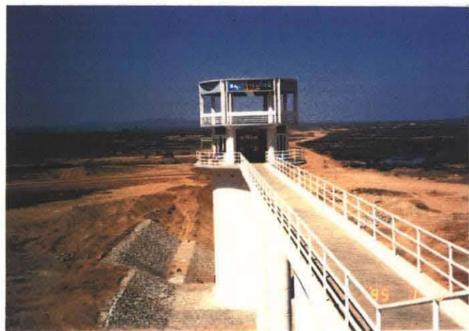
NGA MOE YEIK ダムの取水塔と底樋
