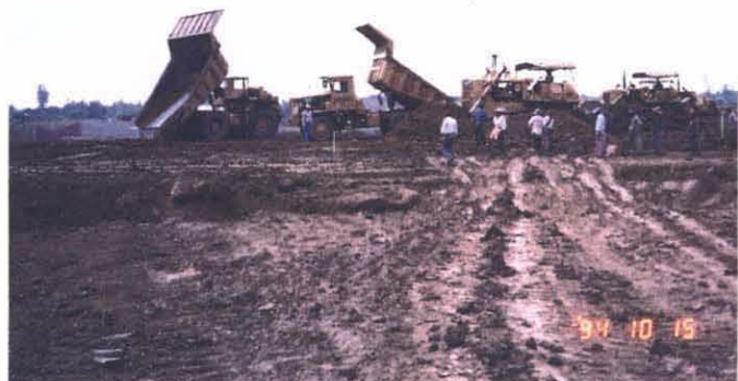
南ナウイン地区、堤体盛土工事 (OECFローン)
