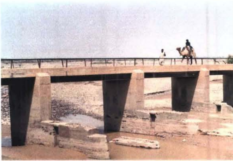
改築を陳情されている洪水調節兼取水堰
