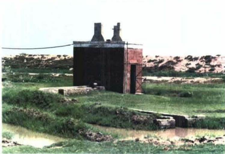
地下水の揚水機場（ラホール郊外） 手前の地表水システム圃場用水路 （Water Course）に補給する
