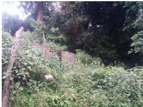
写真-4 既存タンク (外観)
