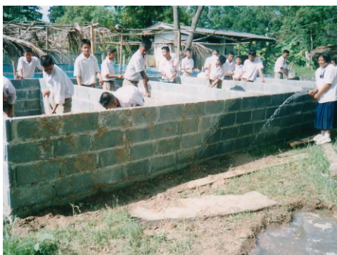
工事中の養殖池（2m x 4m、5池）
