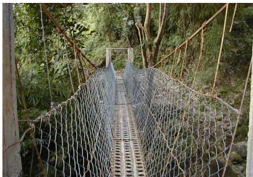
完成した吊り橋歩道橋
