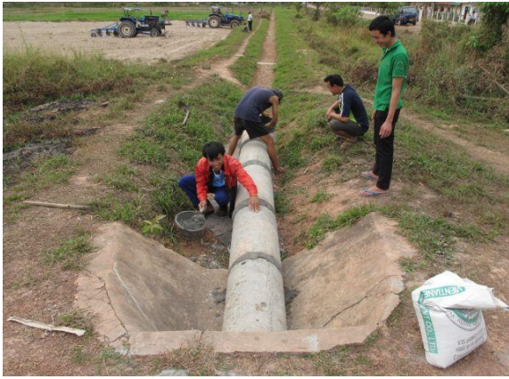
教師も率先して作業、奥は区画整地工事作業、
