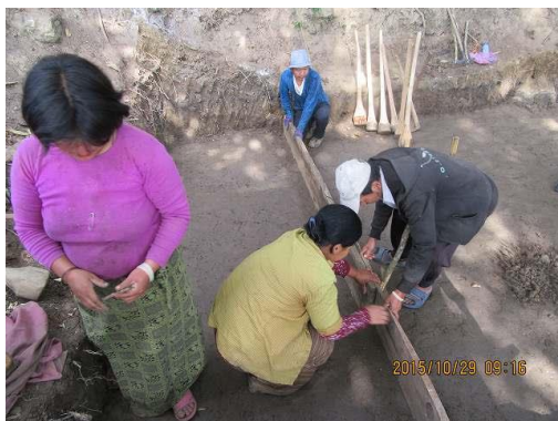
池底の軟弱地盤はセメント安定処理
