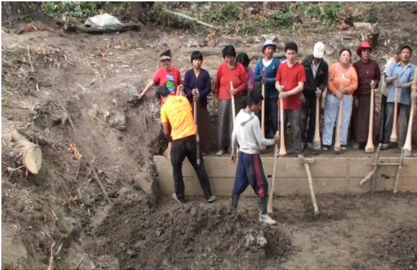
人力による壁面の締め固め
