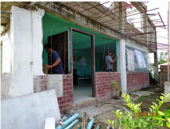
修復中の施設
