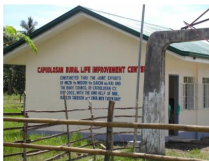
完成した多目的農村センター
