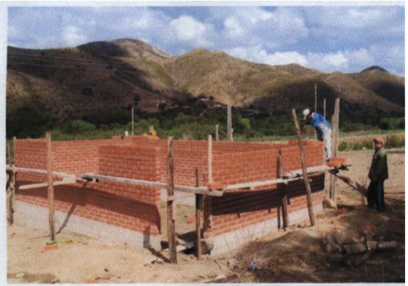
建設工事の様子
