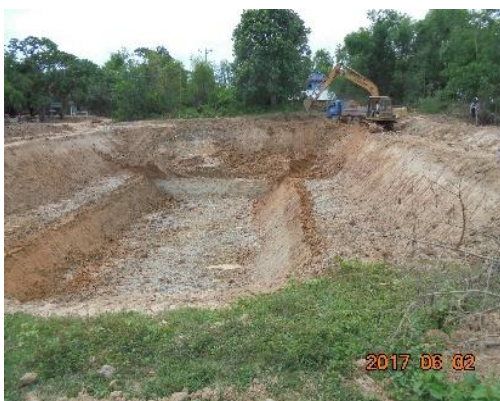
掘削完了間近。
