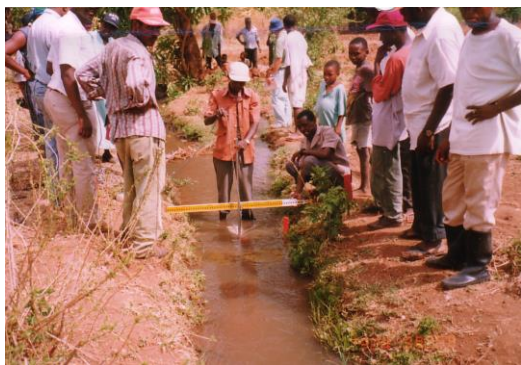
整備予定の土水路
