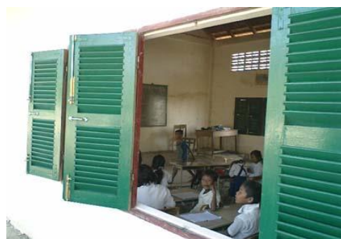
修復された窓
