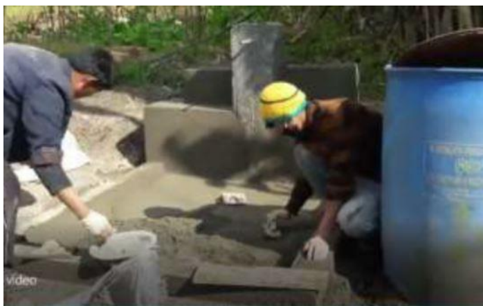
新規水源受水溝の整備
