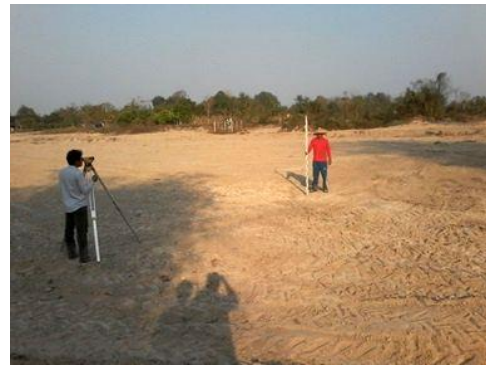
平坦度施工管理
