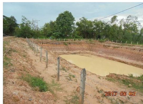
8月完成した貯留池に雨水が貯まり始める
