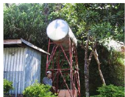
完成したタンク
