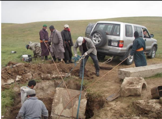
井戸修理工程
