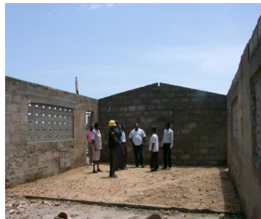
修復中の教室の壁と屋根
