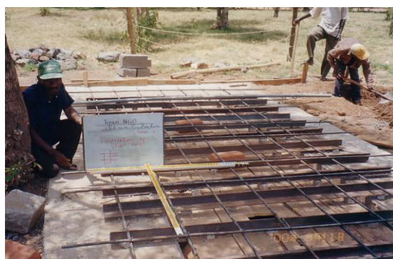
トイレの基礎建設中
