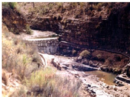
完成した堰と水路
