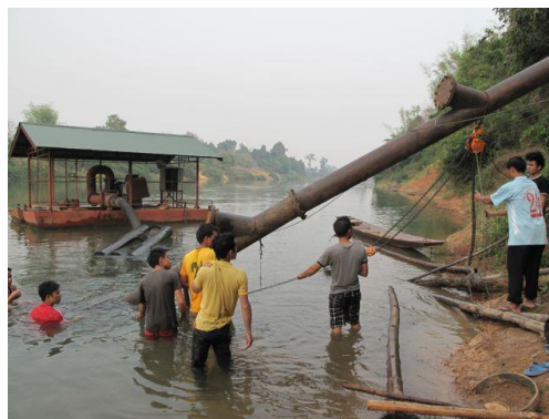
送水管位置替え作業
