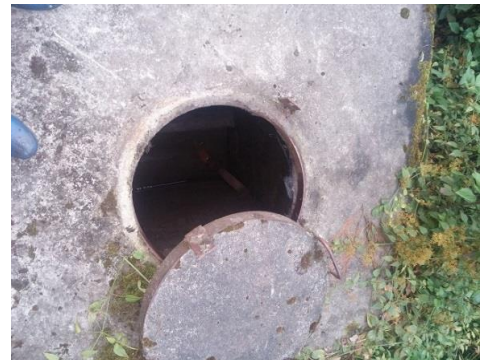
写真-5 既存タンク (上部)
