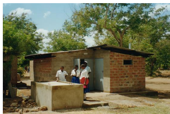
完成したトイレと手洗い場
