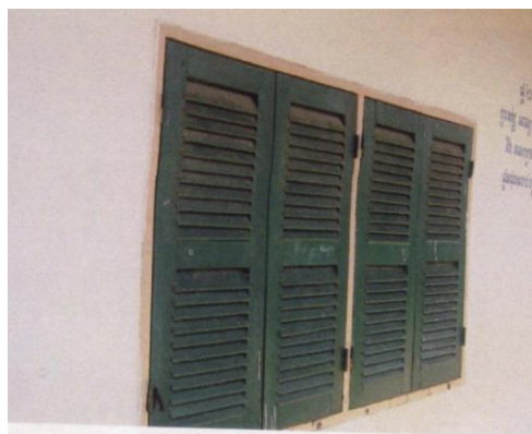
支援によって修復された窓
