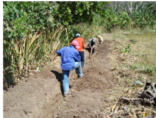
パイプ設置のための掘削
