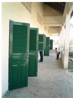
修復されたドア
