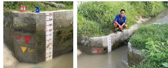
写真 2: 配水管理システムの改善 (各二次水路の始点に設計流量の水位をマーキングすることで、ゲート操作者が農家に対して根拠を持って適正流量を説明できるようになった。)
