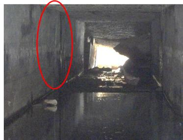
写真2 横断排水工劣化状況：側壁を通じて目視で漏水が確認された。
