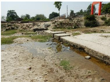
写真1 用水路サイホン劣化状況：河川流の洗堀に加え、本体に亀裂が生じ漏水している。
