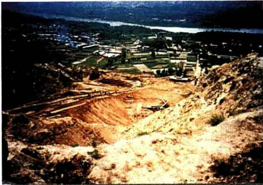
地すべりにより損壊した送水パイプの 改修工事
