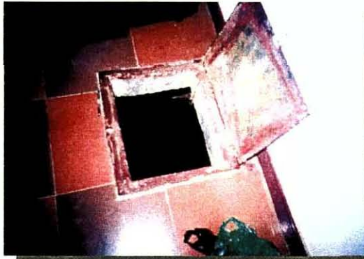
一般家庭での貯水タンク
