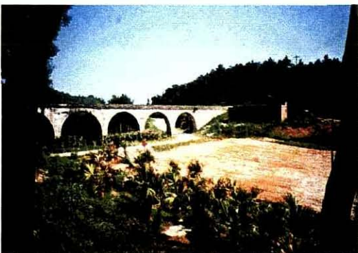
丘陵地における農業用水路 (ポンプ場水で用水を確保している)
