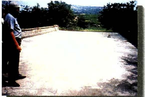
雨期の雨水を受けとるための一般家屋の陸屋根
