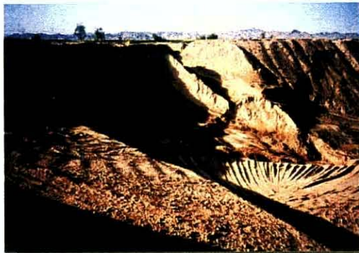
地すべり箇所
