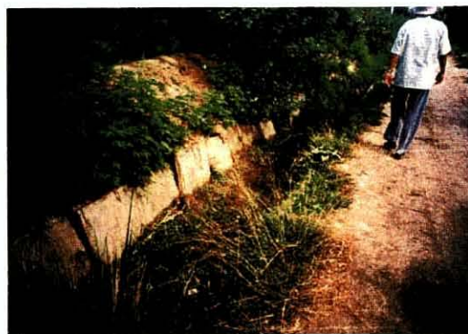
老朽化の著しい水路ライニング
