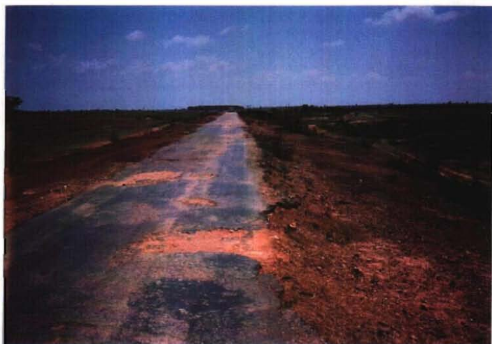
地域内幹線—維持管理・補修がされていない
