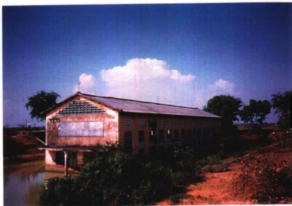
ポンプ場—使用されていないまま、荒廃している
