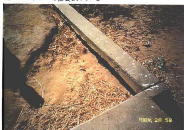
ファームポンド側壁外縁の部分 オーバーフローで侵食されている
