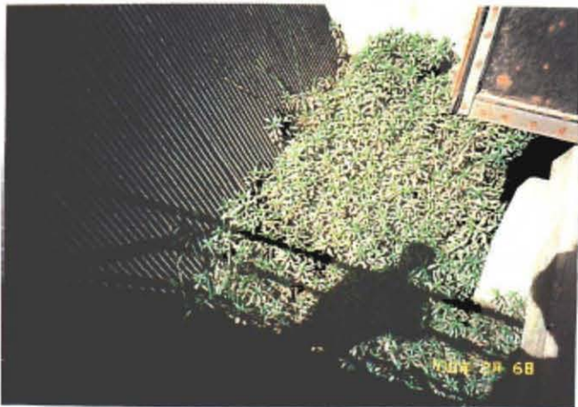
吸水槽スクリーン部の状況
