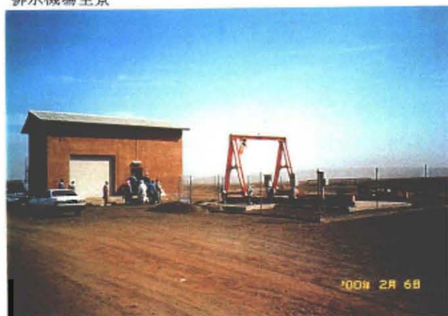
排水機場全景
