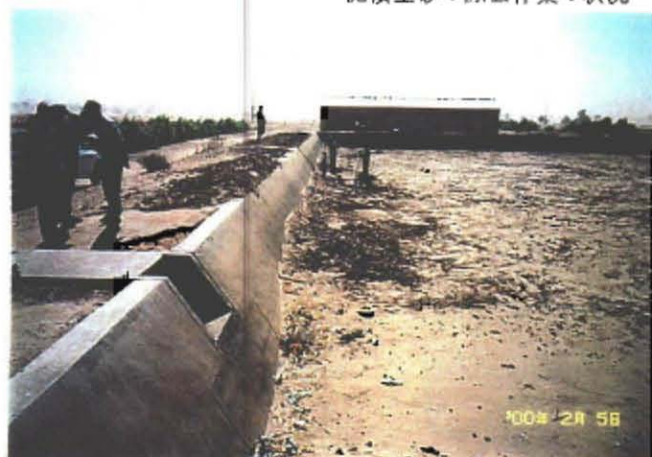
ファームポンド 沈積土砂の除去作業の状況
