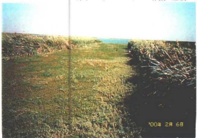
セネガル川からの取入れ口 毎年のようにメンテナンス作業が必要
