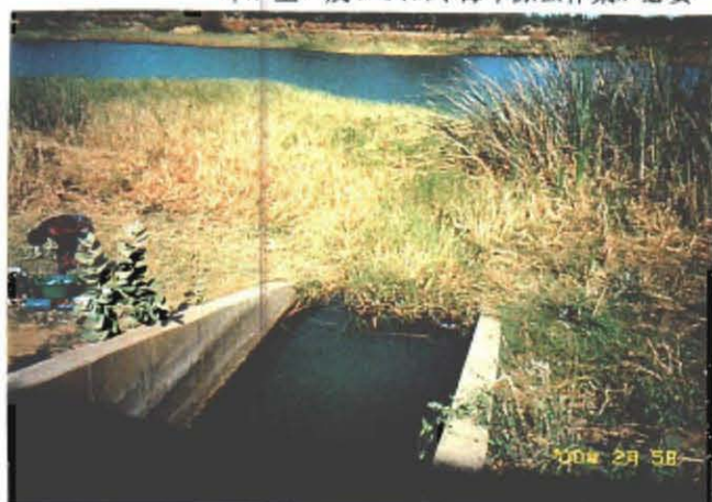
灌漑ポンプ場、吸水槽流入部 草が生い茂っており、毎年除去作業が必要
