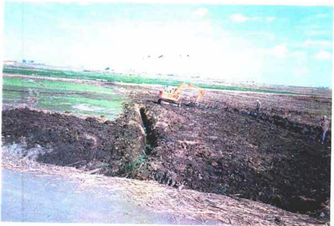
排水溝設置による乾田化
