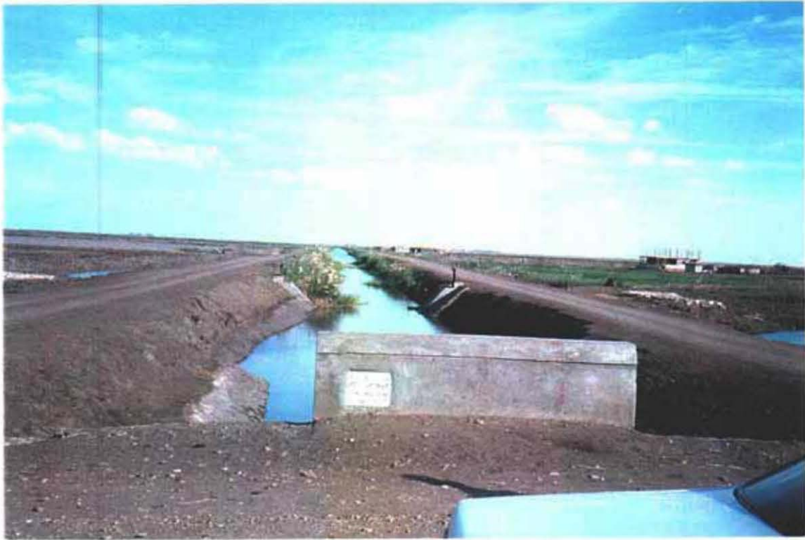
2次支線水路と分水工
