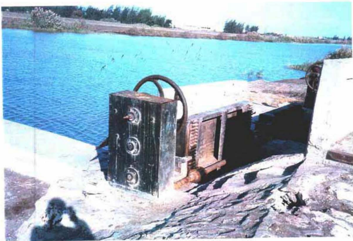
幹線水路の分水工ゲート
