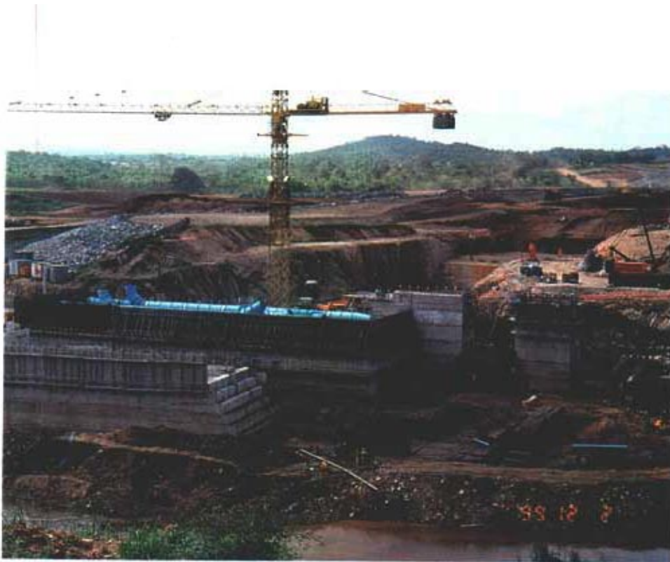
ムトテダム建設現場（洪水吐及び遠方は左岸盛り土）
