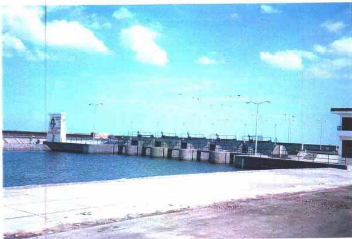
第4ポンプ場下流側の Head Regulator (水位調整ゲート)
