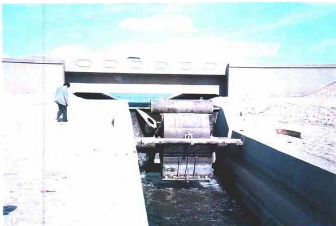
分土工下流水位制御ゲート
