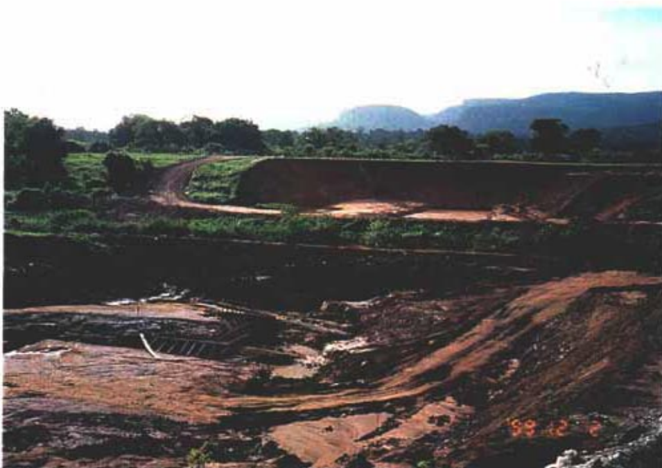
キクンデ取水堰（床堀状況）
