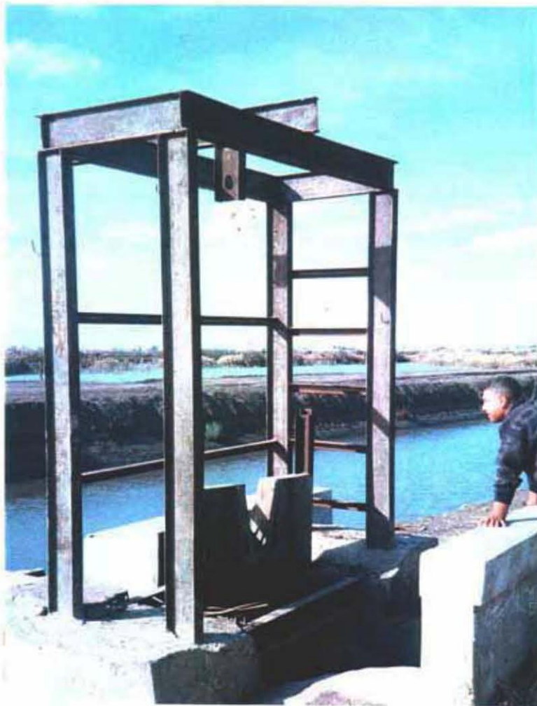
管理が困難な取水ゲート
