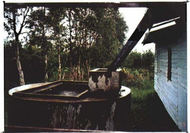
飲料水用雨水タンク
