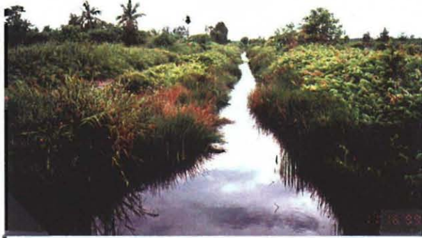
バランバイ潮汐低湿地スキームの排水路と未利用地
