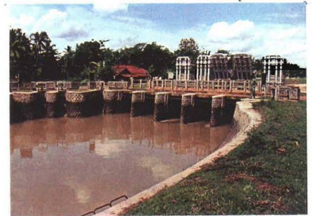
ワイスプティ灌漑幹線水路の調整水門
