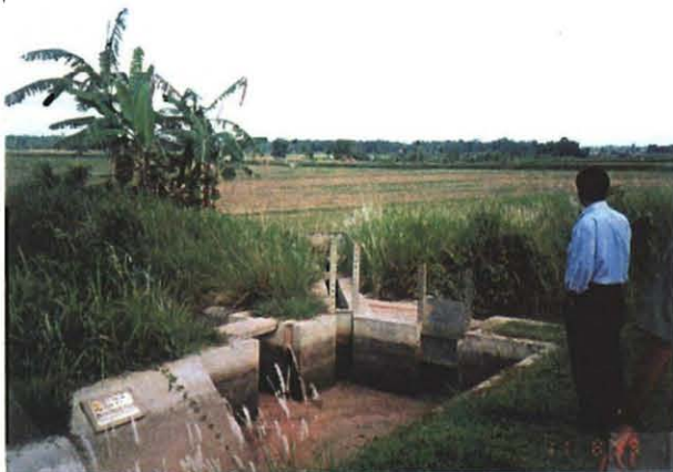
支線水路から第3次水路への分水工
