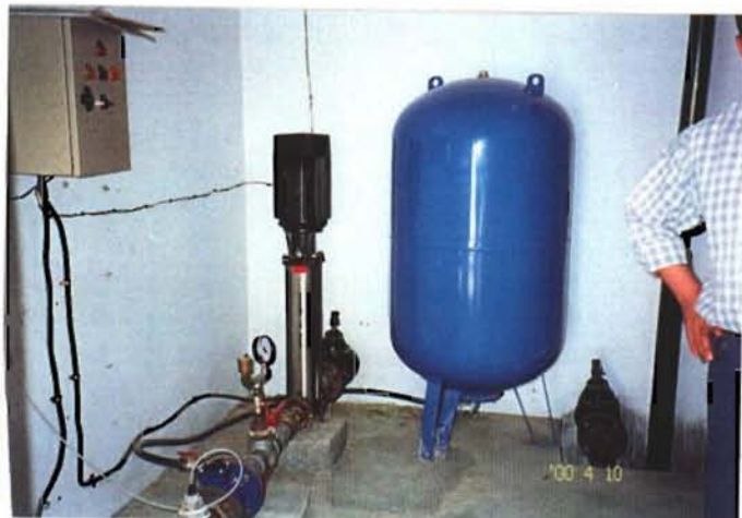
送水用ポンプ及び調圧水槽(Ben Arous 県)
