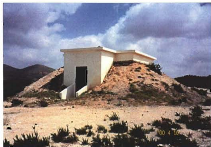
丘頂上に設けられた配水池(Ben Arous 県)
