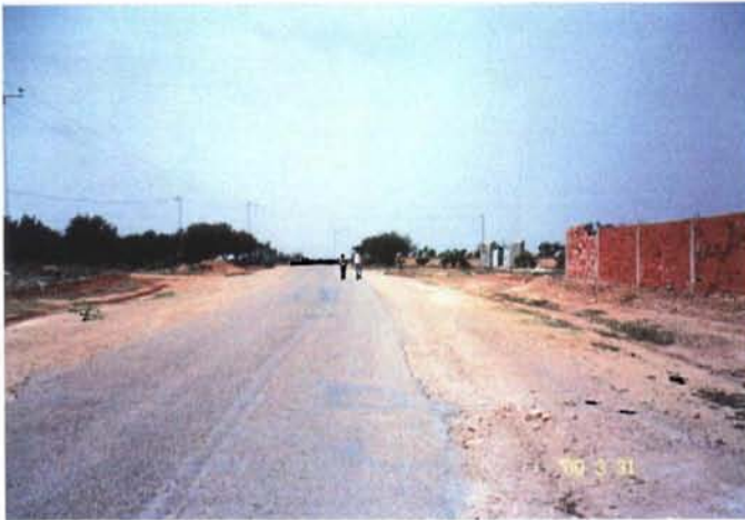
この道路に沿って給水地区まで配水管が設置される(Sousse 県)
