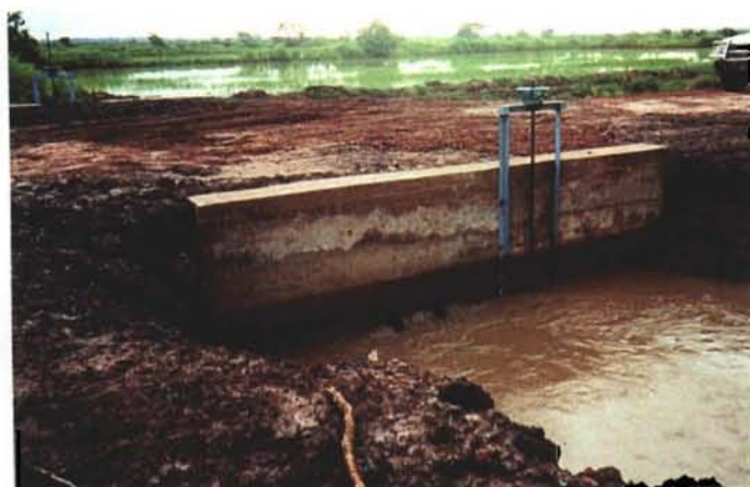
防潮調節施設
