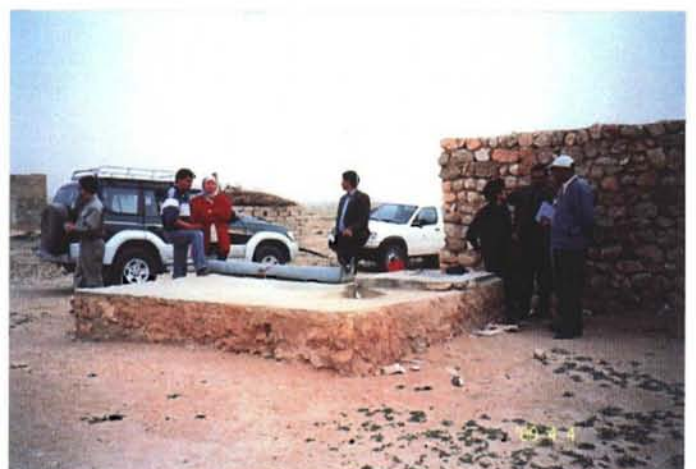
運ばれた水は地下の水槽に貯え、バケツ等により汲み上げて使用している(Gafsa 県)
