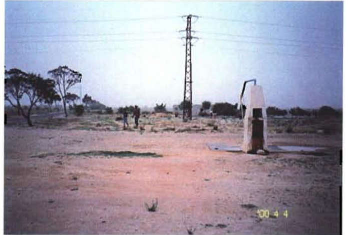
高架水栓(Gafsa 県)
