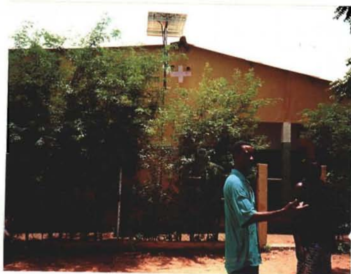
太陽光発電設備を備えた保健衛生施設
