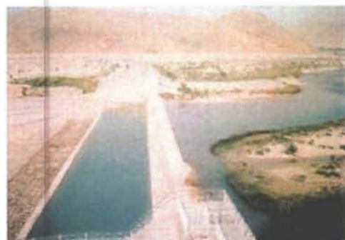
Balan 川上流部にある灌漑計画取水工 (Balan Weir Irrigation Scheme)
