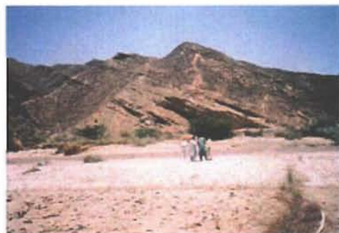
Hingol ダム地点 左岸アバット予定地
