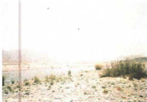
Naulong ダム地点を下流より望む
