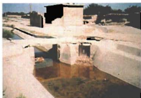
Bund Khushdil Khan プロジェクトの 幹線水路上流部
