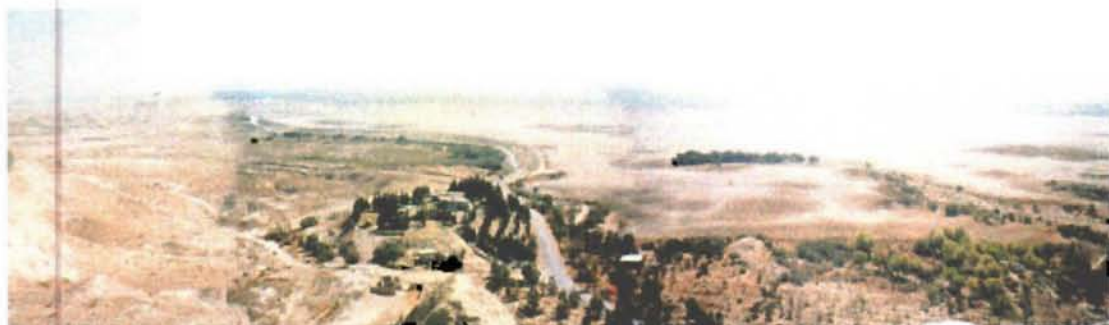
Bund Khushdil Khan プロジェクトのダム及び貯水池 貯水池には堆砂があり、水がなく湖底が現れている
