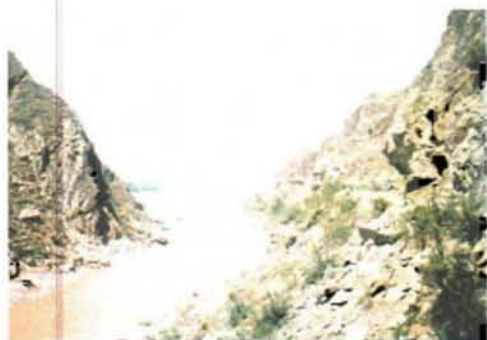
クラム・タンギ ダム地点 下流より上流を望む
