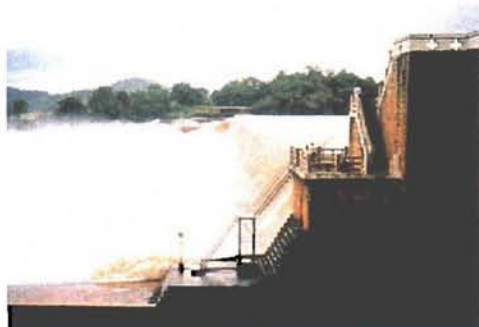
既存のトゥンガ取水工 雨期のこの水が灌漑に利用されていない。 取水工の下流部に新設取水工を計画している。
