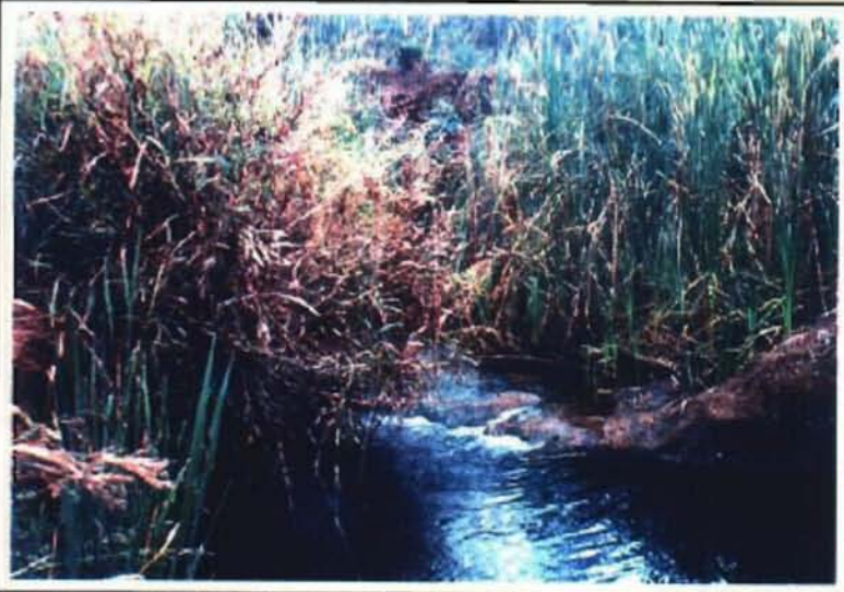
灌漑水路の侵食
