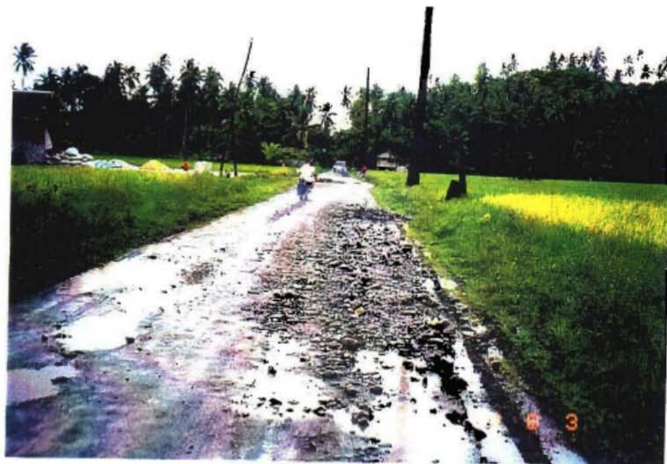
リグラベリング作業中の道路（締固め前）
