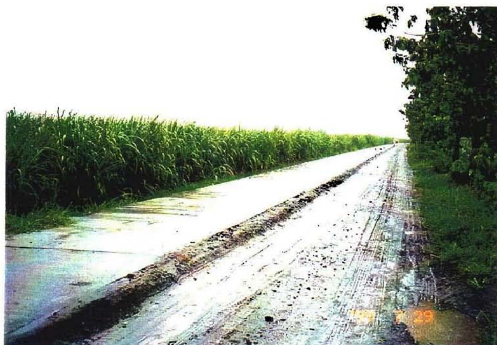
砂利道からコンクリート道にアップグレード作業中（片側のみ完成）
