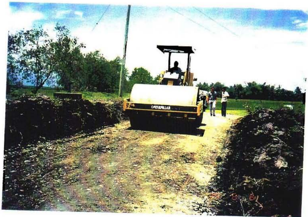
ローラーにて転圧作業中
