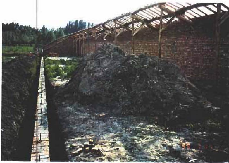
新しく設置している温室施設（レンガ製）
