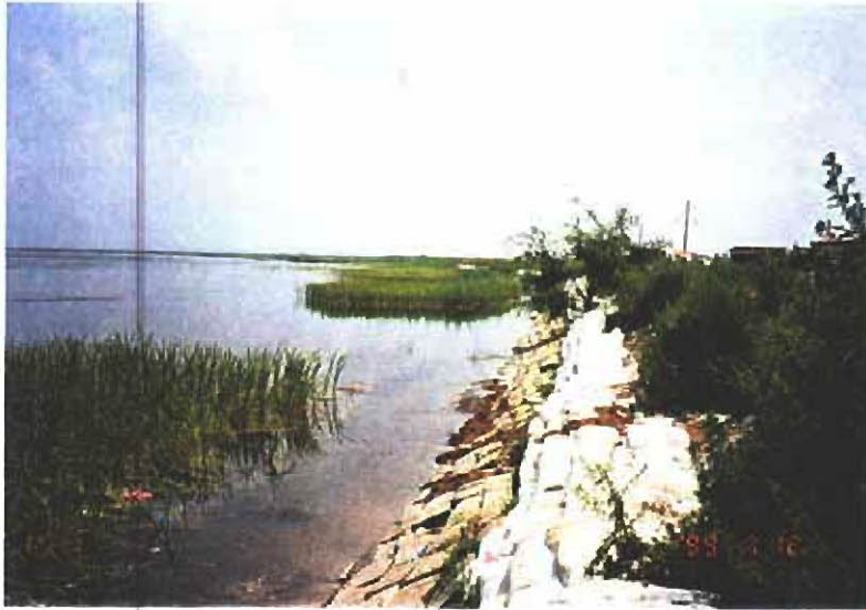
東升ダム（平原水庫）堰堤
