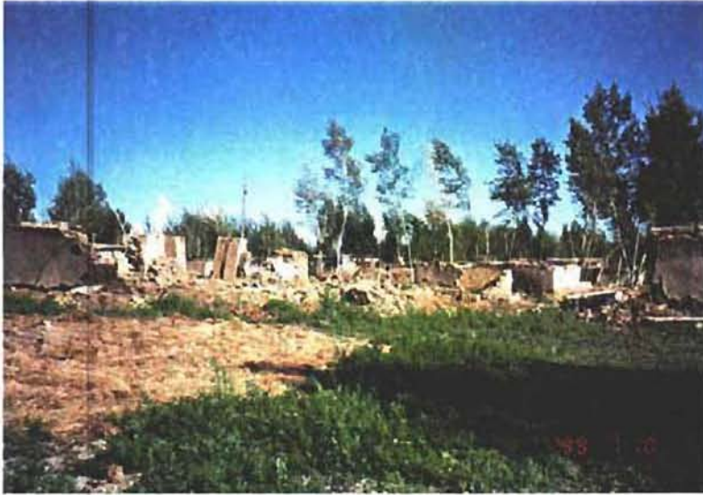
四合郷地区の洪水被災による家屋崩壊の状況 ほとんどの農家は日干しレンガ家屋のため洪水によって崩壊している
