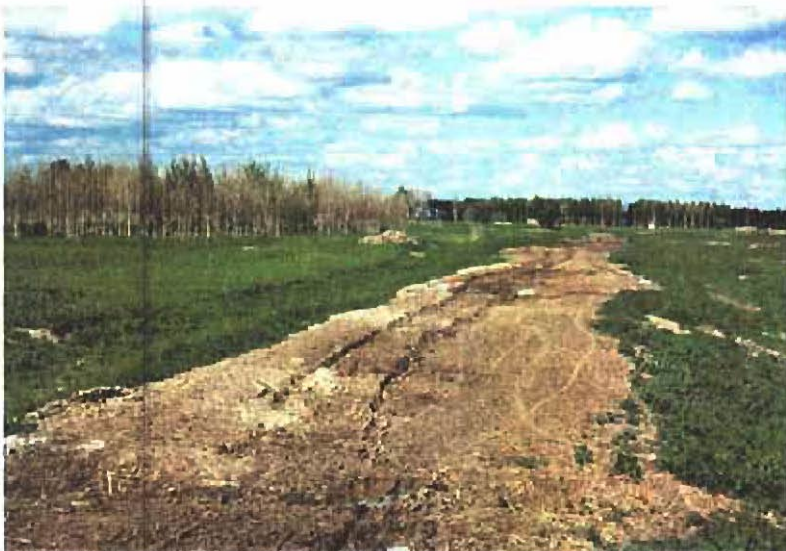
同上堤内地の湛水によって枯死している林地
