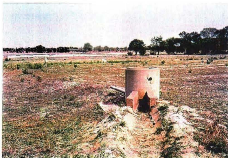
ブルキナ・ファソ 畑地内水路の取り入れ口
