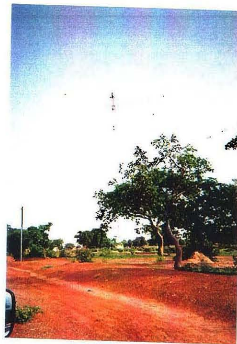
ブルキナ・ファソ 太陽光発電方式による 通信施設
