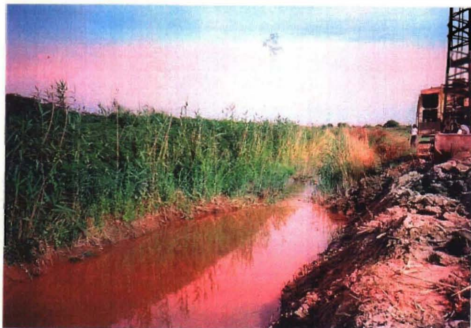
同、手前は浚渫後、前方は 浚渫前の状態(同)
