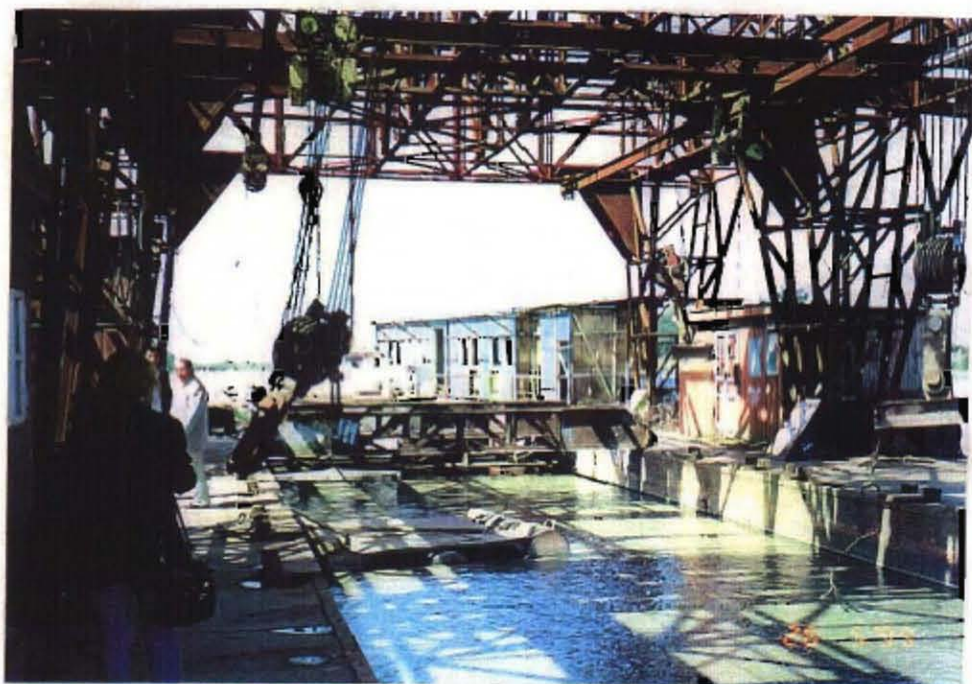
Ali-Bairamly Floating Pump 修理工場
