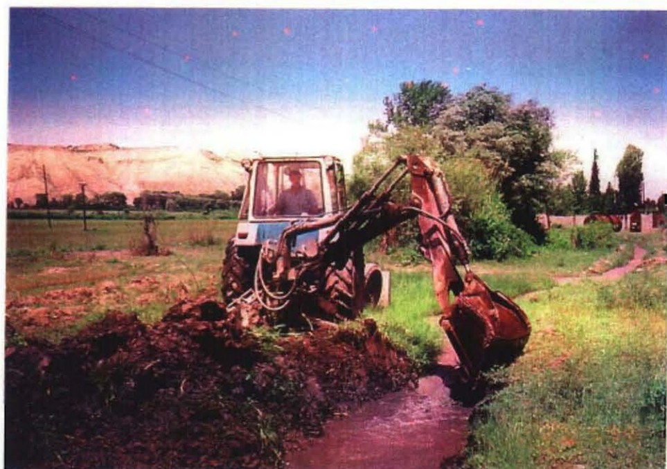
車輪式エクスカベーターに よる小水路の浚渫作業 (Agdash)
