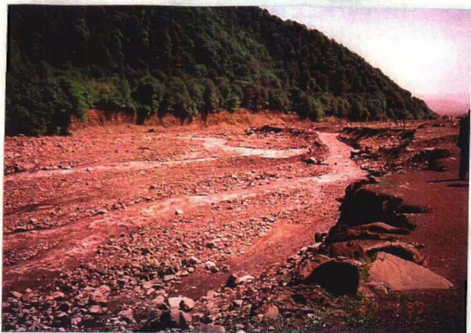
洪水により洗掘された堤防 (Damir Aparan River, Gabala)
