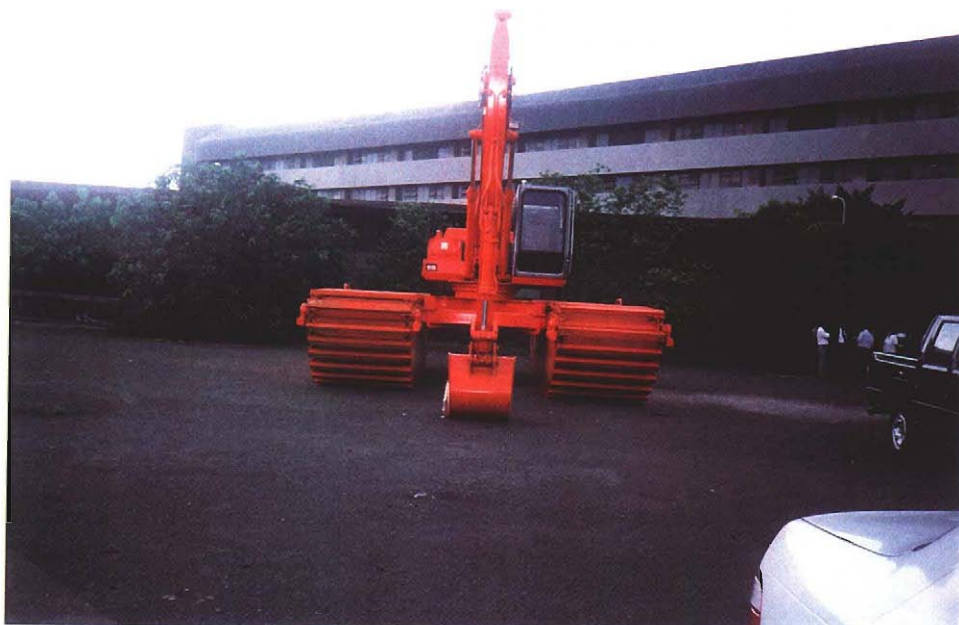
パンパンガ州へ 搬出予定の 超湿地掘削機械
