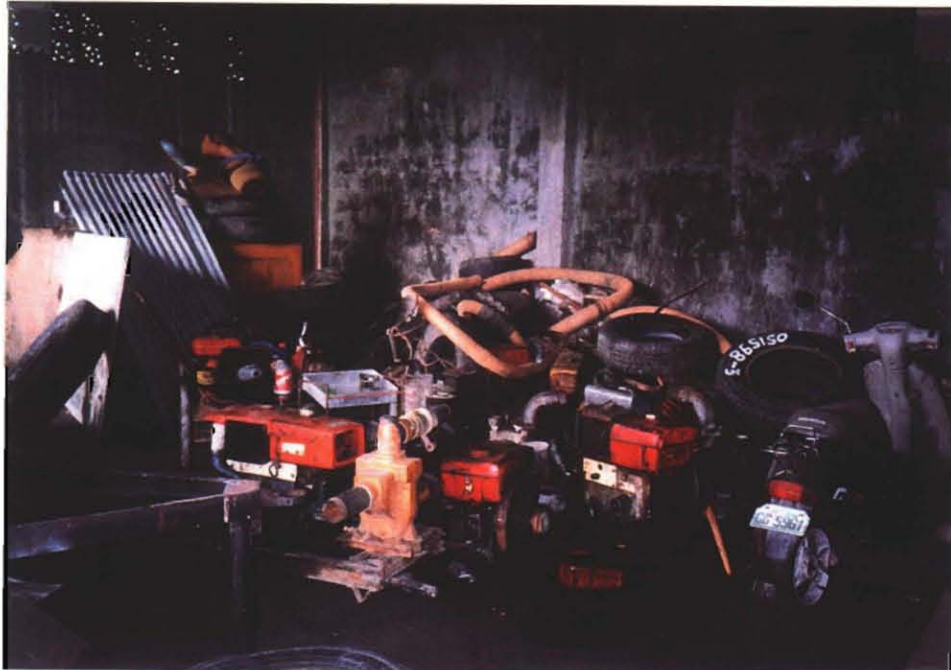
使用不能の ポンプ
