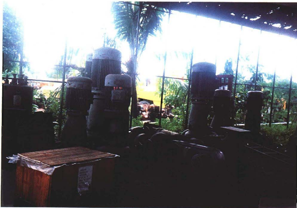
使用不能の ポンプ
