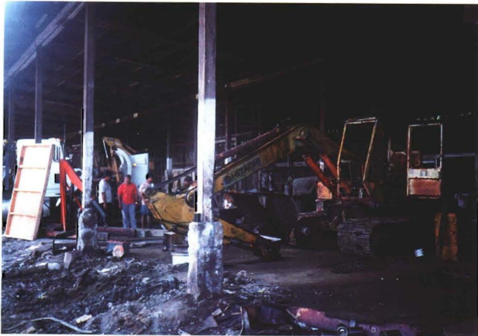
修理中の 建設機械
