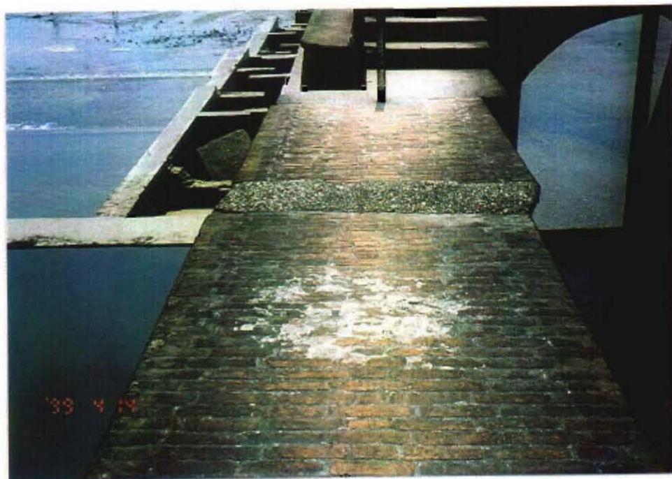
チャンドラ堰 地震により取水壁中央にクラックが生じ、コンクリートで補填している、1999/4/14
