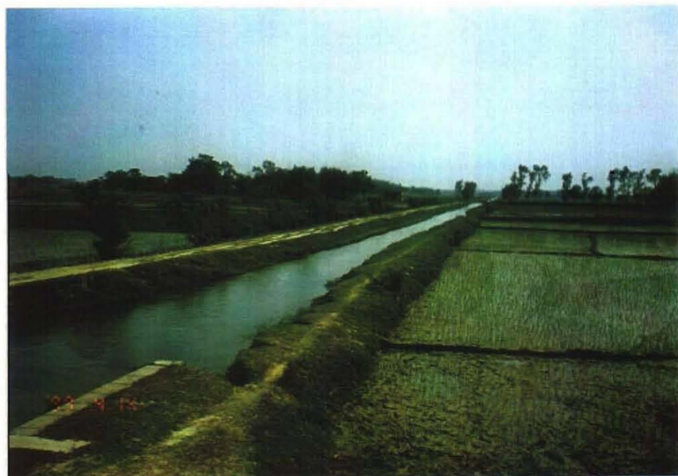
コシ西部水路左岸の支線水路 約11cu.m/secを取水している、1999/4/14
