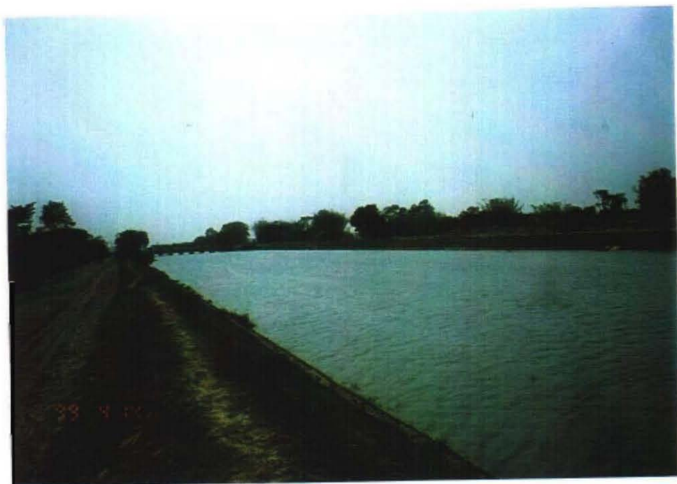
コシ西部水路 約20cu.m/secの取水を行っている、1999/4/14
