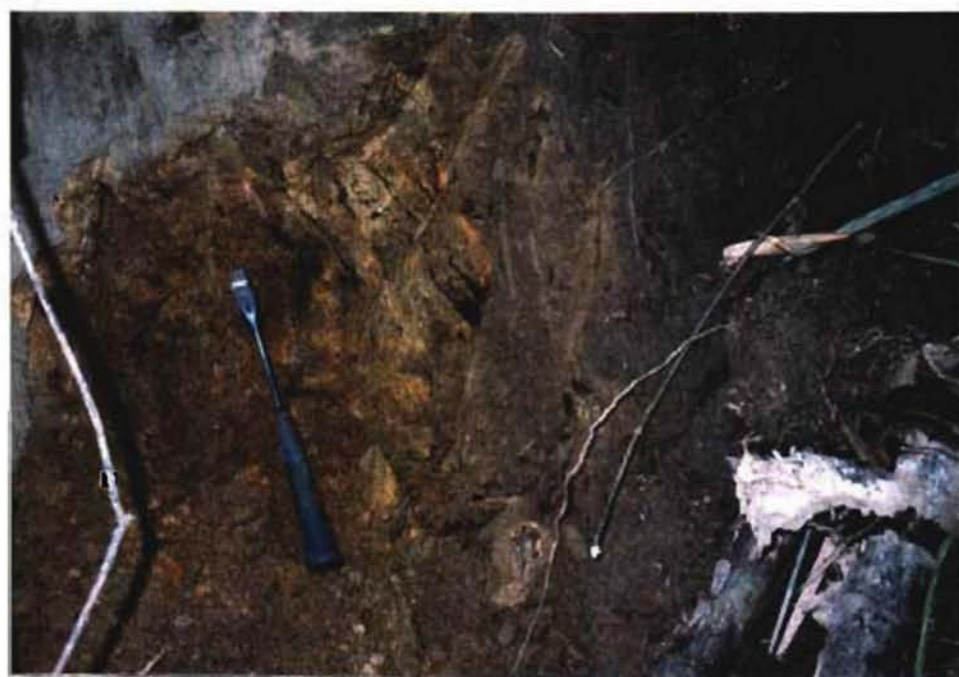
写真 3-11 カバウン計画頭首工地点の右岸川岸の露頭
