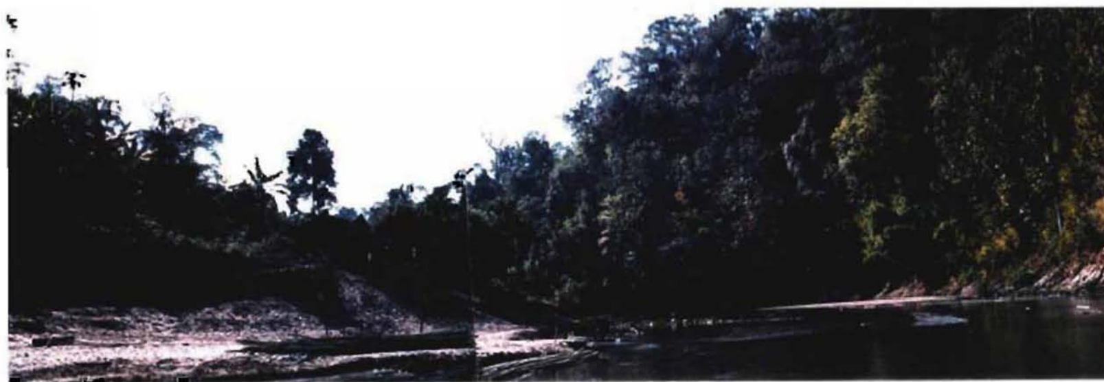
写真3-4 カバウン発電所放水口付近
