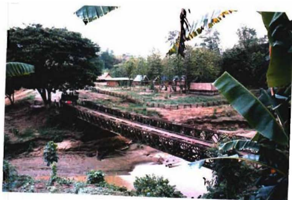
写真 3-6 カバウン貯水池区域（既設道路橋）
