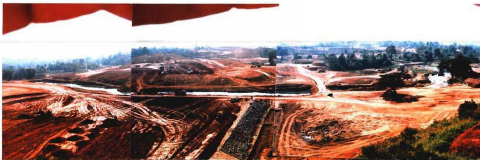
写真1-3 バティダム建設状況（ダム築堤全景）
