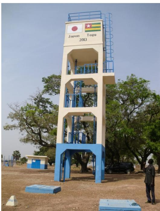
図4：レベル2施設の給水タンク（3m毎に中床版と最上部貯水タンクへのアクセス階段を設置している）
